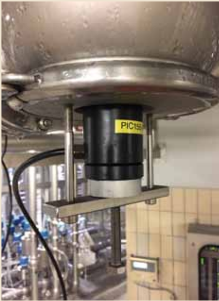
Abb. 2 Befestigung der Ultraschallsonde am zylindrischen Drucktank mittels Varivent Housing
