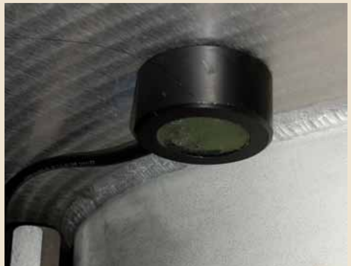
Abb. 1 b Spezielle Verklebung der Sonde direkt am Tankboden
